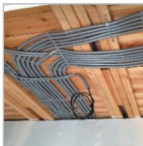
Благодаря тому, что металлорукав изготовлен из негорючего материала, его можно применять при прокладке проводки по сгораемым поверхностям.
